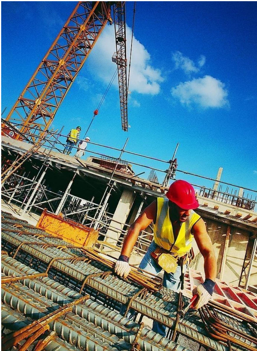
图 1 为建筑工程施工现场
